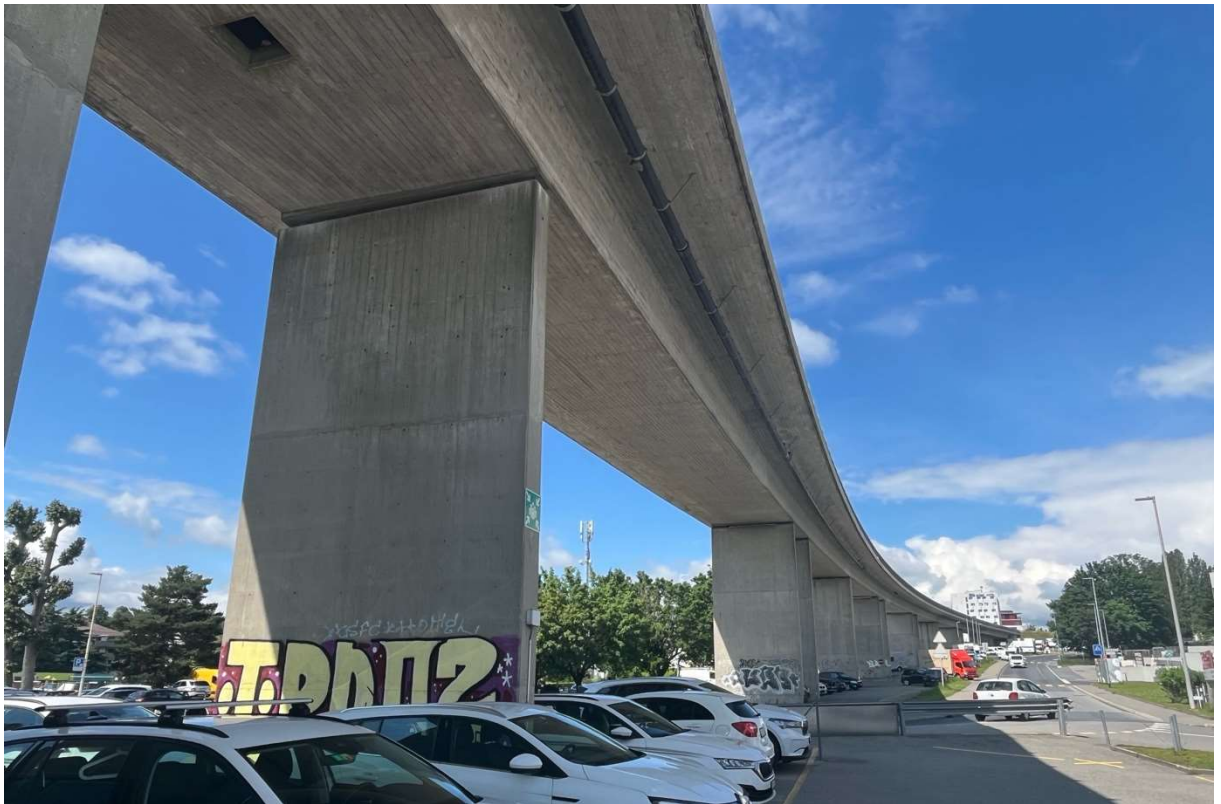
Figure 2. Photo de l'ouvrage
